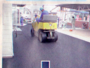
サンドブラストによる 表面処理
