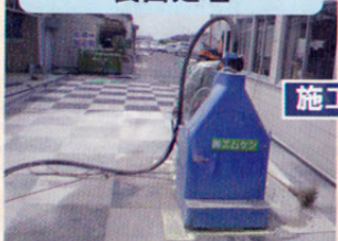
サンドブラストによる 表面処理
